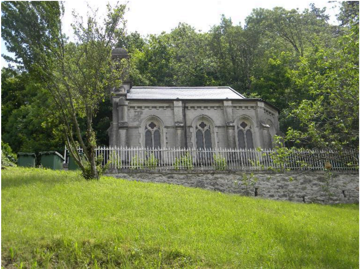
Vue de la façade latérale nord.
