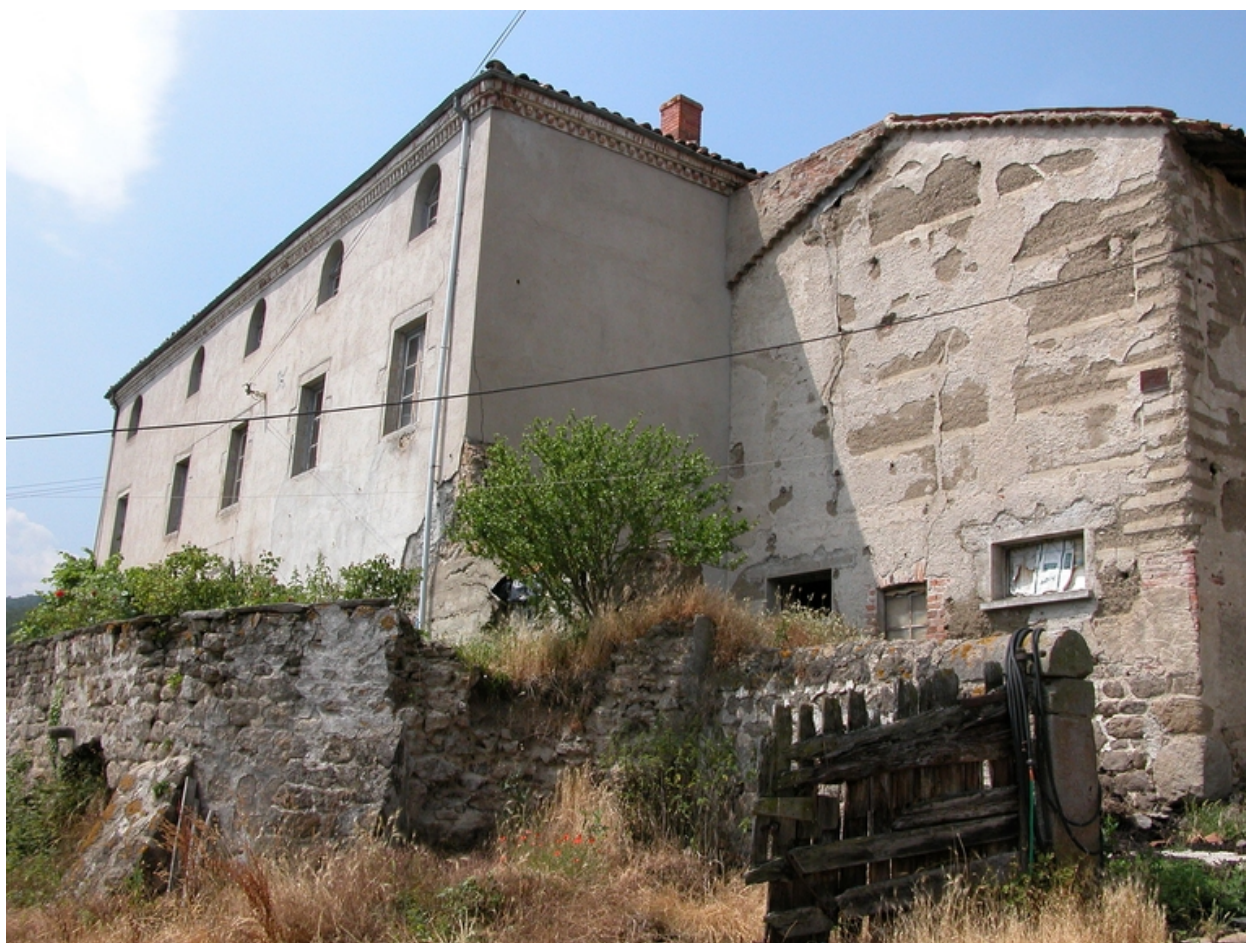
Vue depuis le nord-est (à droite : pignon du bâtiment sud de la ferme, avec ouvertures de l'étable).
