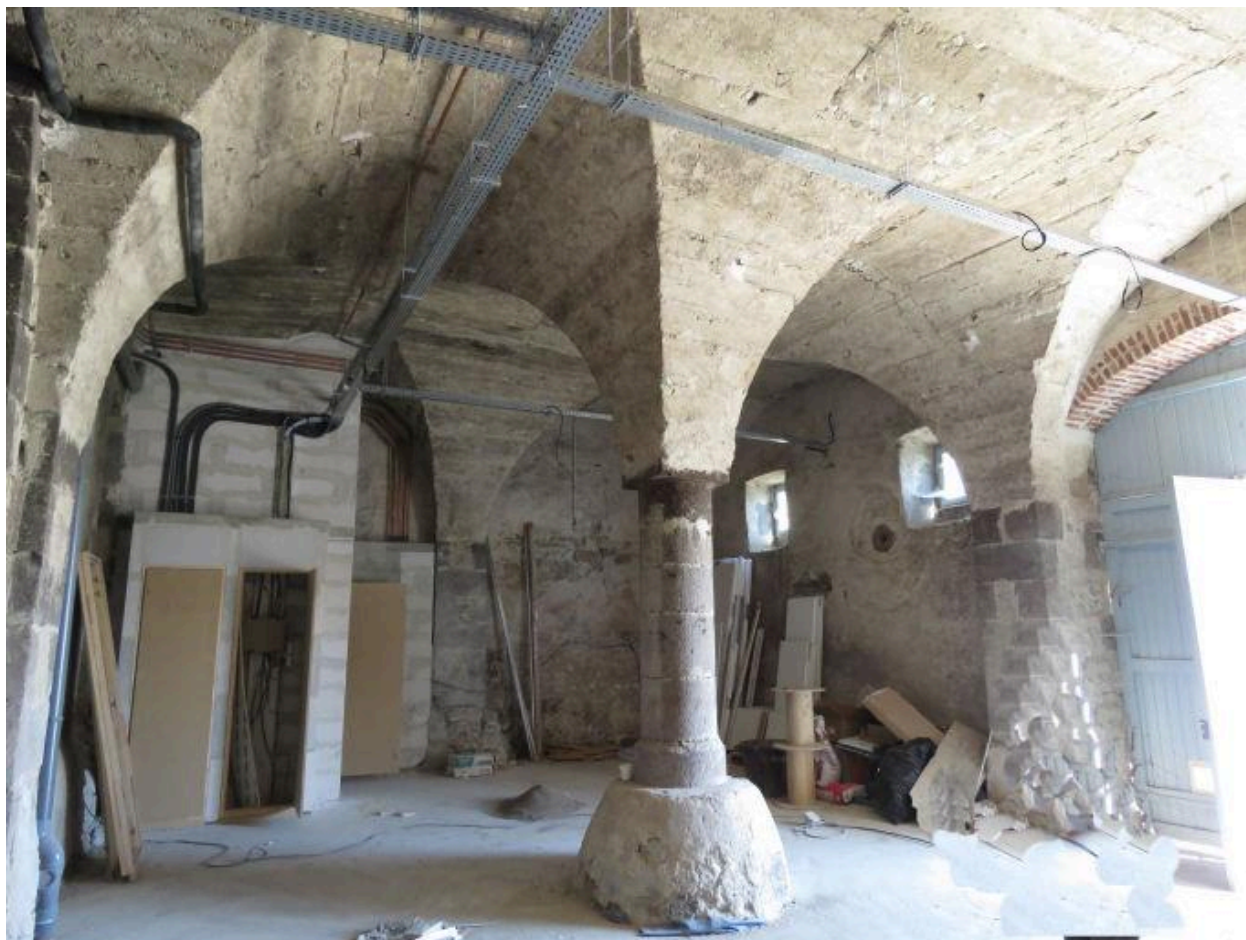
Vaste cuvage en rez-de-chaussée : Cournon, 33 av. de Lempdes)
