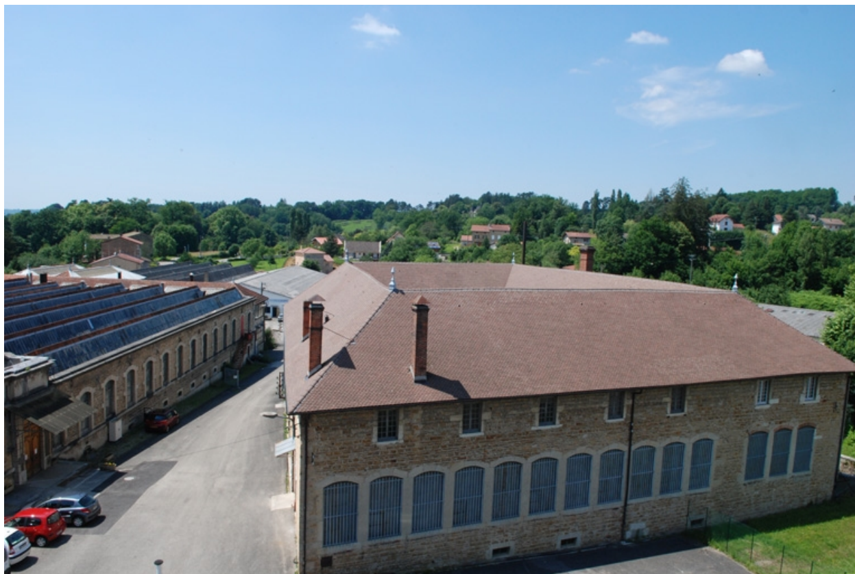
Vue extérieure bâtiment de la forge
