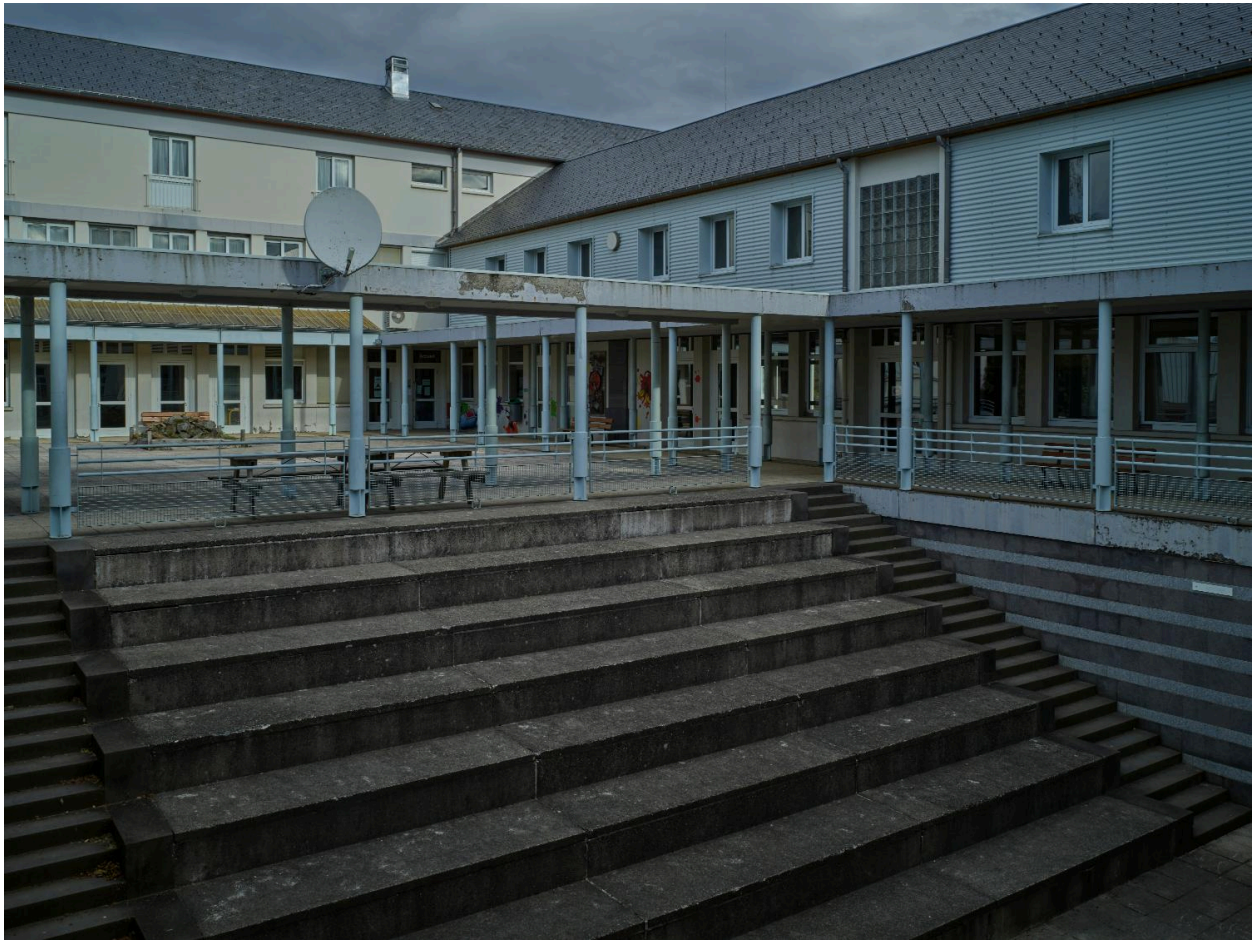
Vue sur les gradins et l'angle nord de la cour à portiques.
