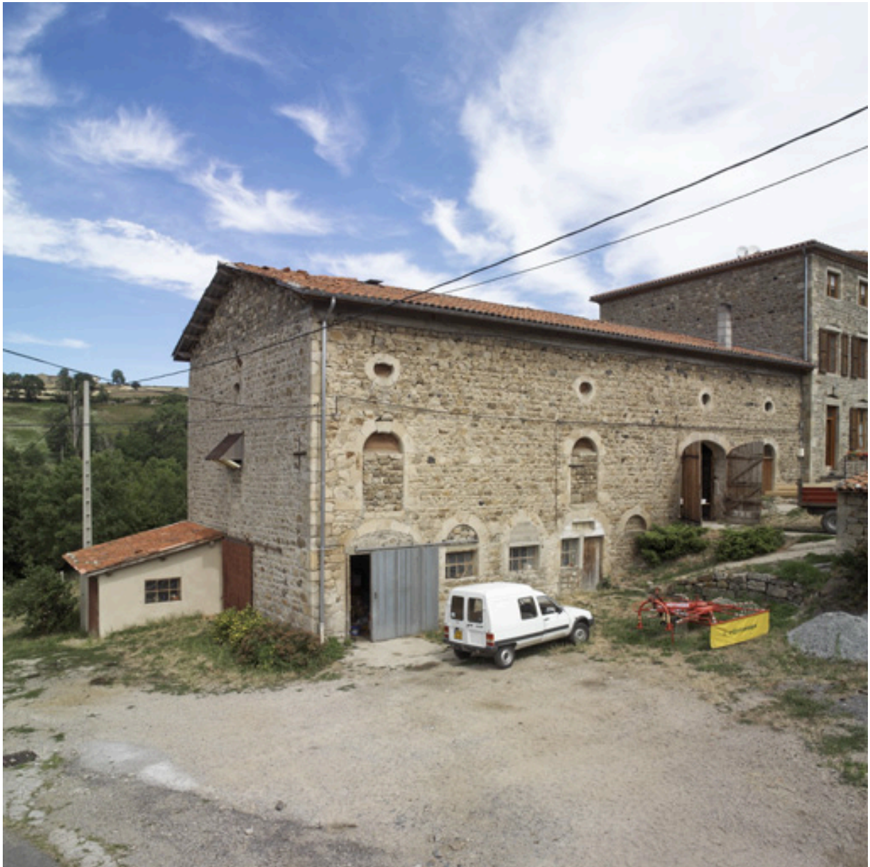
Vue de la grange-étable, depuis le sud-ouest.
