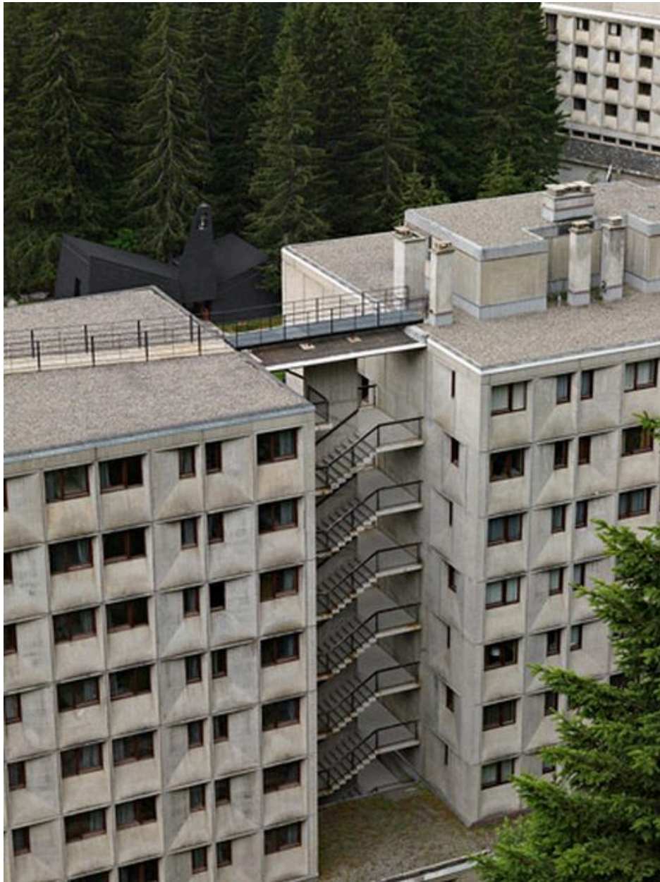
Vue de l'escalier reliant la résidence et l'hôtel depuis Flaine Forêt, au nord
