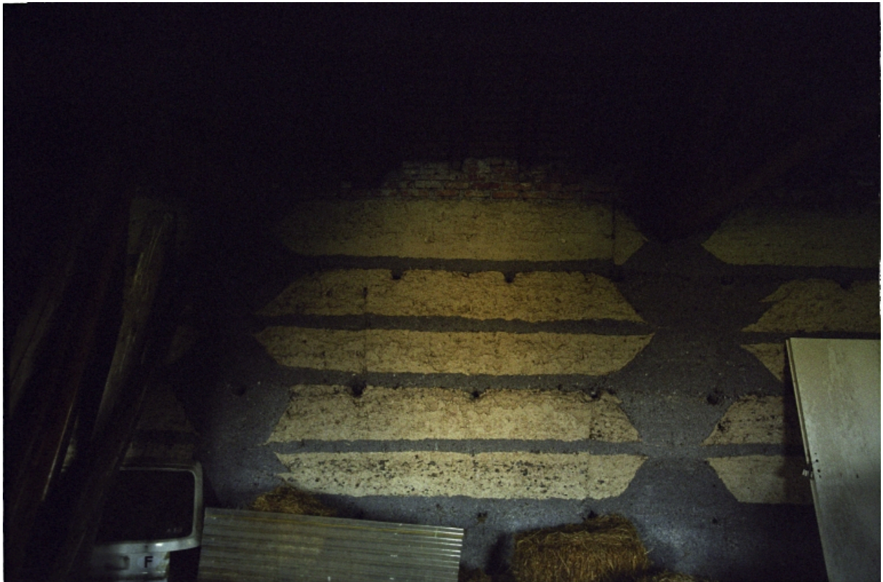
Boën, la Chaux-est, ferme (1986 AE 294). Grange-étable, pisé de terre avec renforts de mâchefer (milieu 20e siècle).
