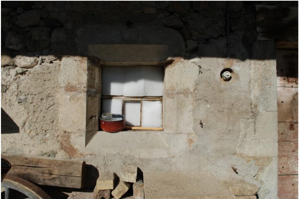
Granges-étables, détail d'une baie à l'encadrement chanfreiné.
