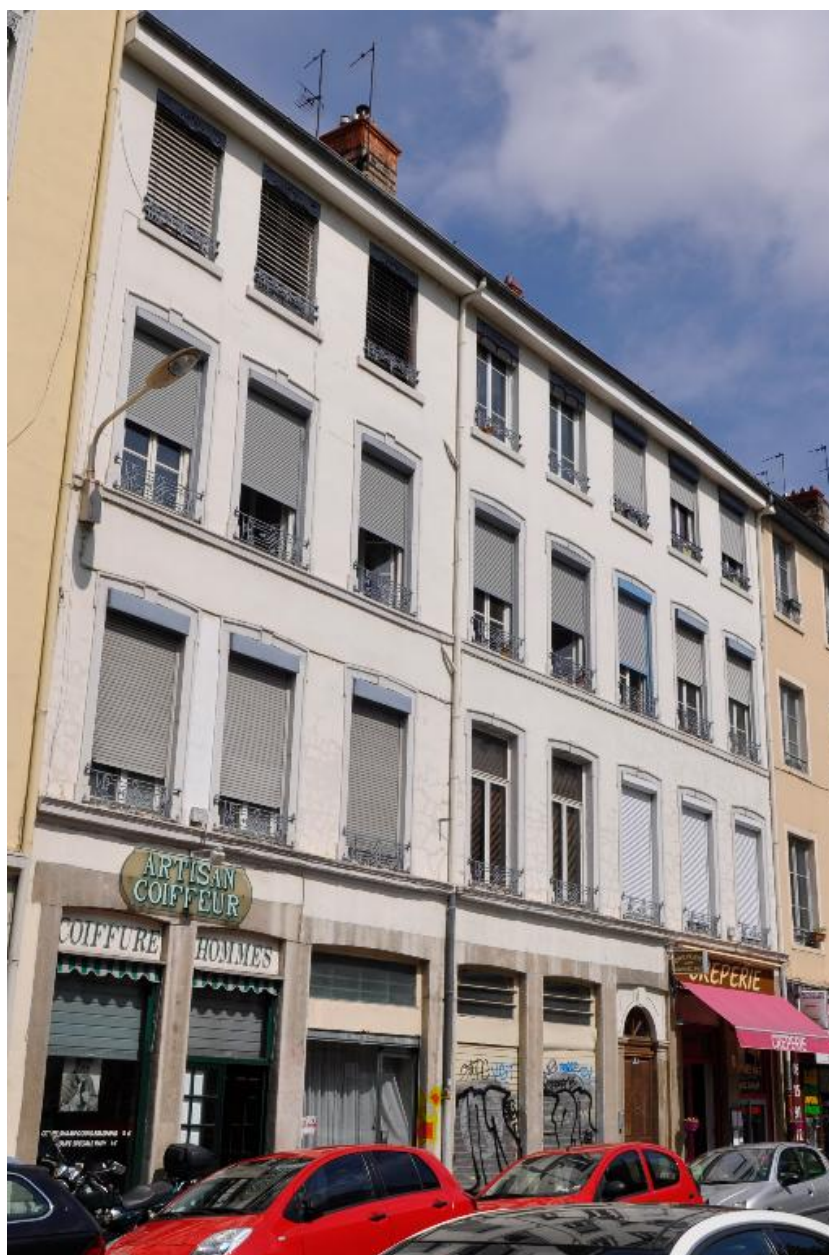
Immeuble sur rue, élévation antérieure
