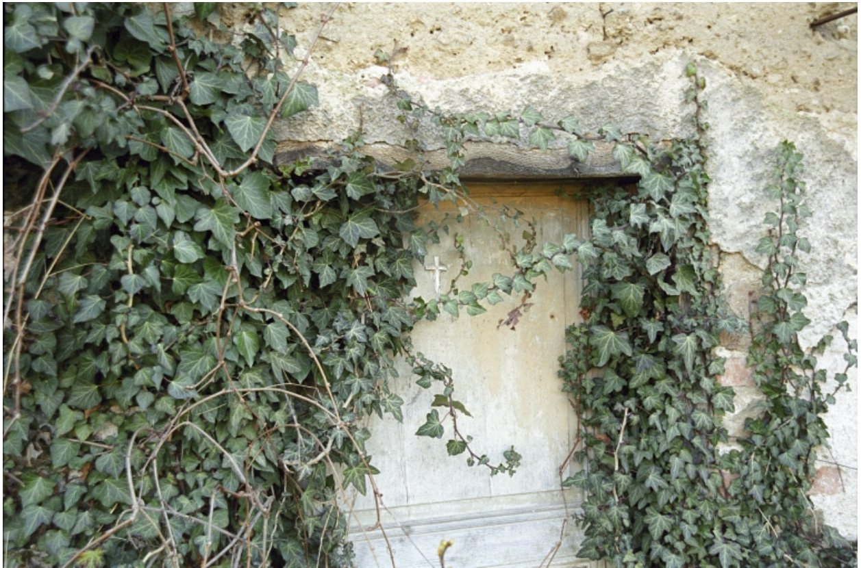
Boën, La Ville (1986 AL 318). Loge de type E1a1. Détail du linteau.
