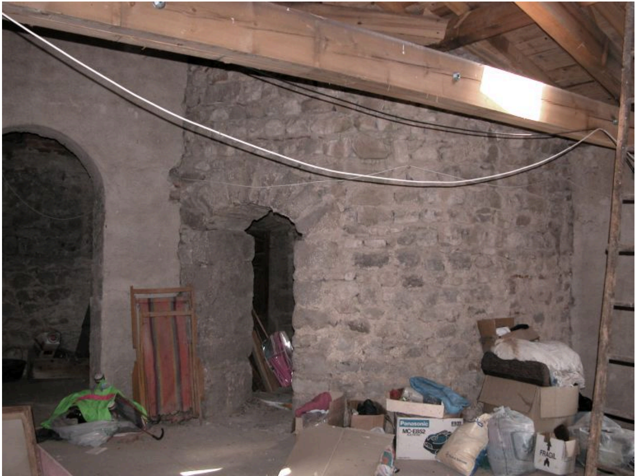
Vue intérieure du comble à surcroît du logis de la ferme.
