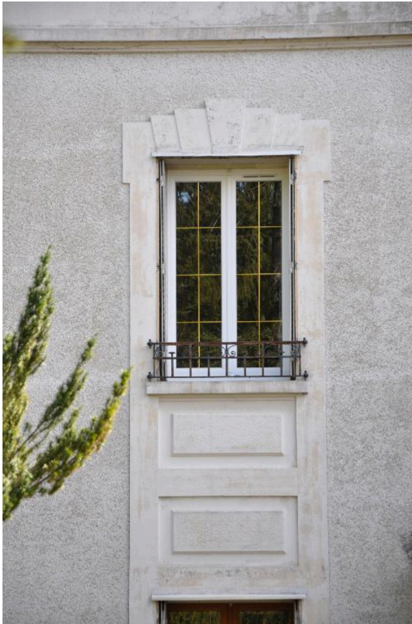
Détail sur une travée de baies à encadrement architecturalé
