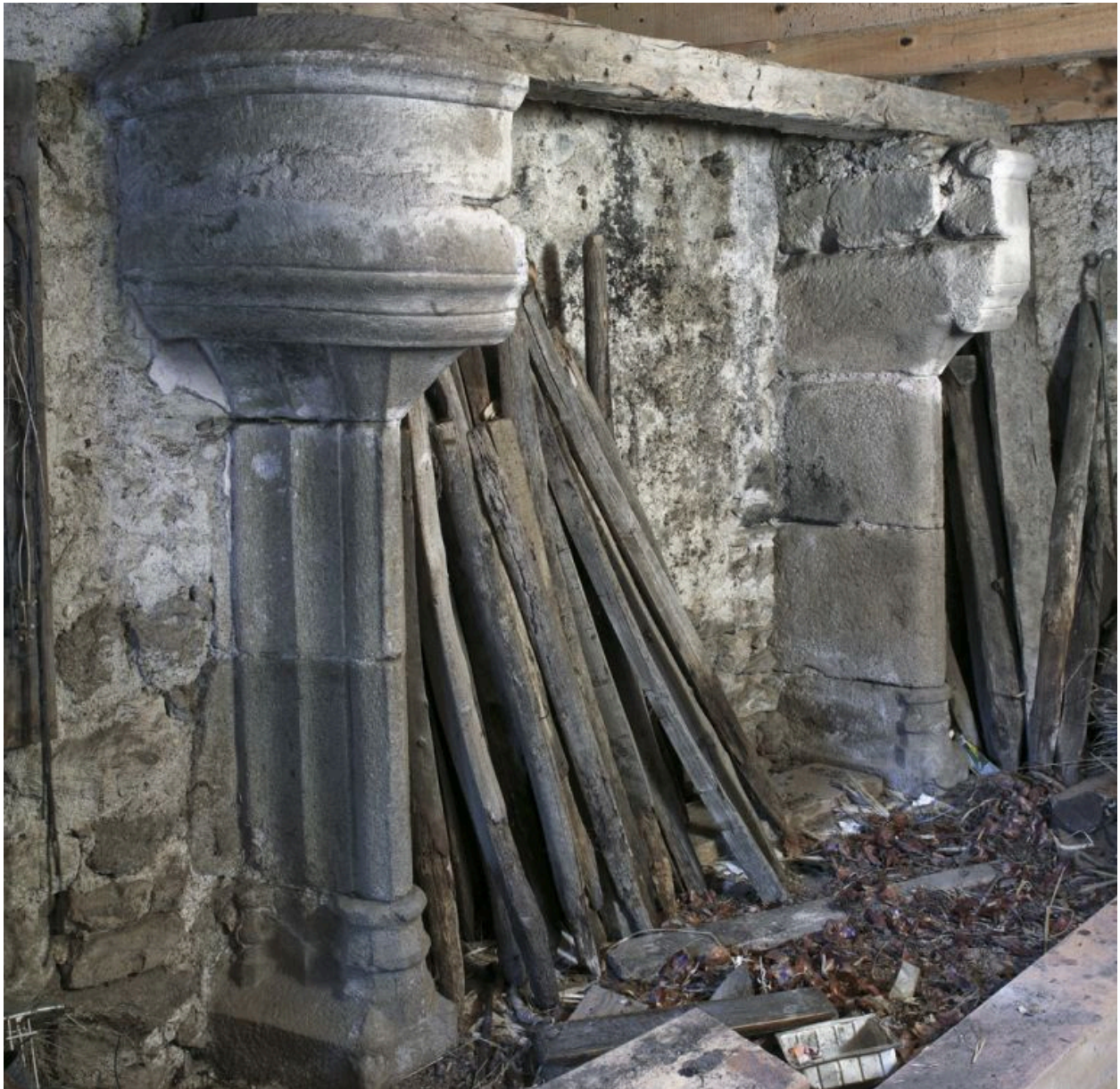
Corps de bâtiment droit encadrant le portail d'entrée : vue d'ensemble d'une cheminée monumentale du 15e siècle située au rez-de-chaussée (le linteau est manquant).
