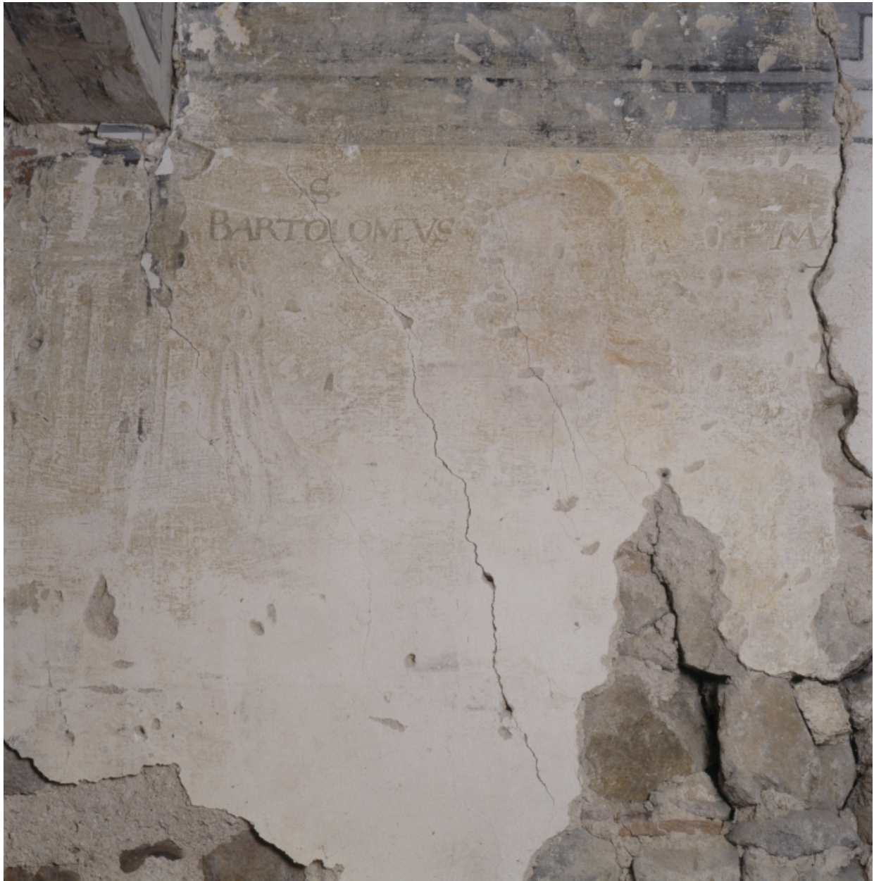
Mur nord-ouest, côté nord : saint Bartholomée et décor de colonne en trompe l'oeil.
