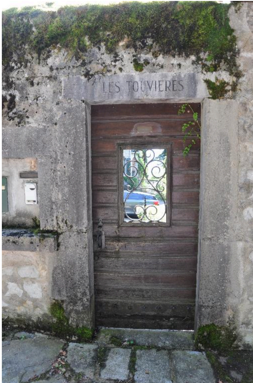
Porte d'entrée et linteau gravé
