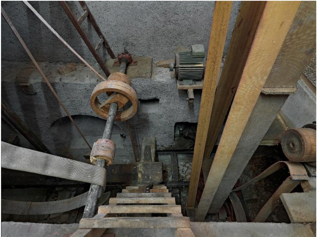
Etage de soubassement : transmission de la roue hydraulique.
