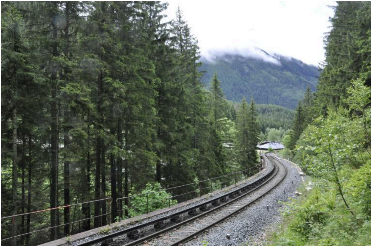
Voie ferrée en sortie sud-ouest du tunnel des Tines allant en direction du viaduc
