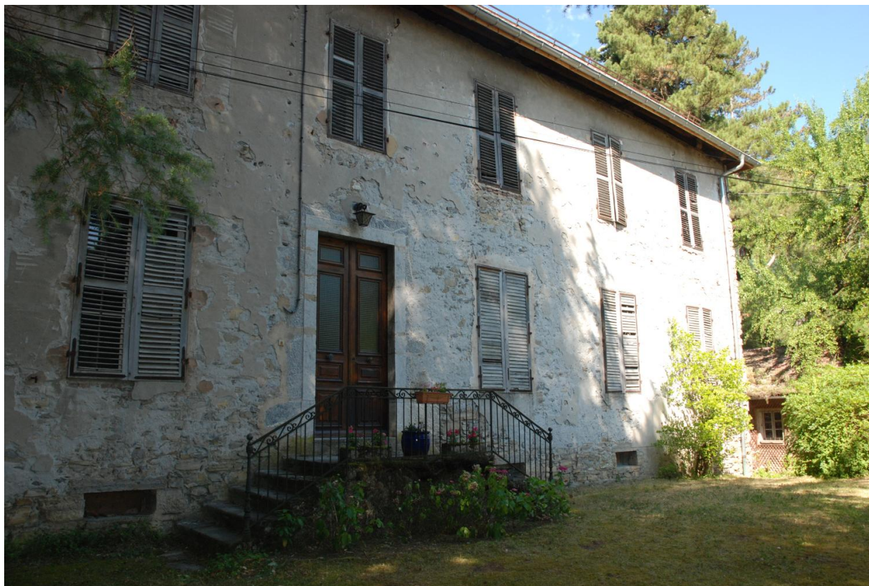
Vue de la façade antérieure.
