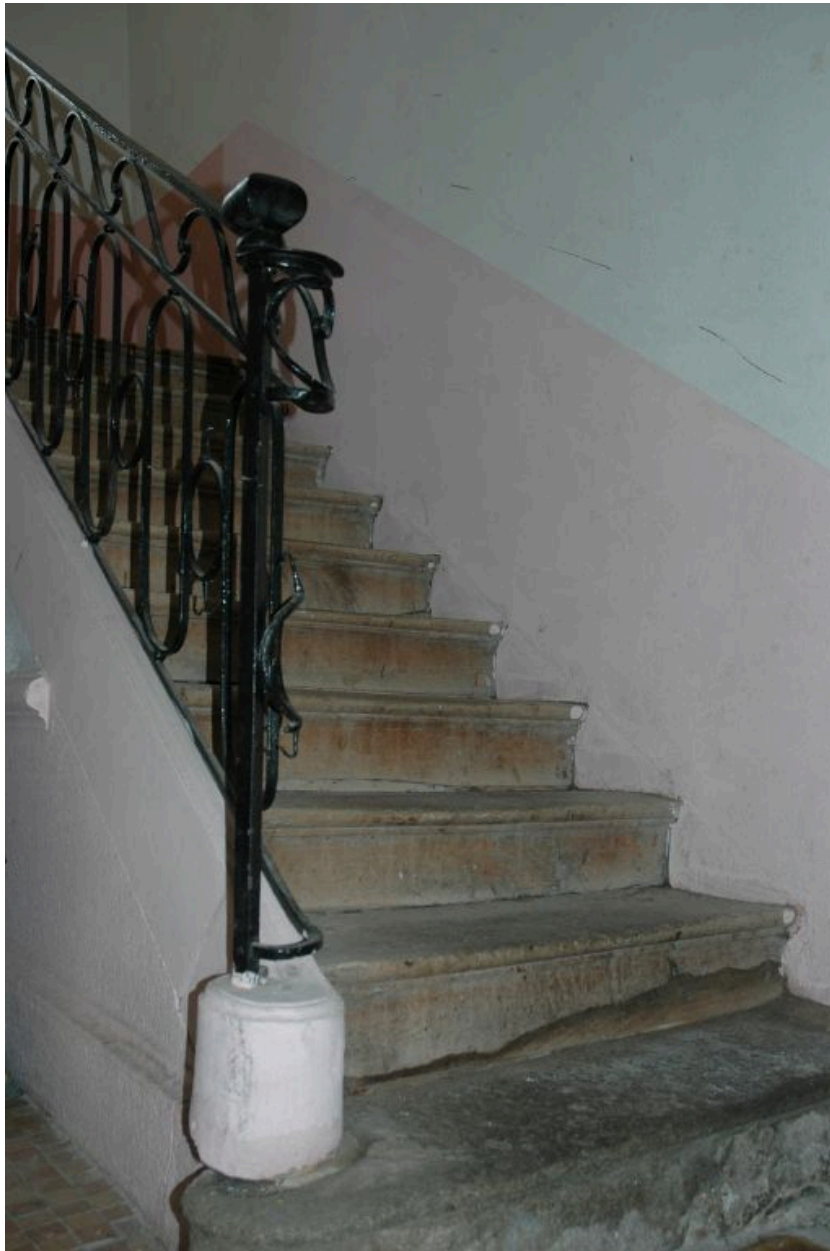
Départ de rampe d'escalier en ferronnerie à enroulement, 18 rue Martin-Bernard.
