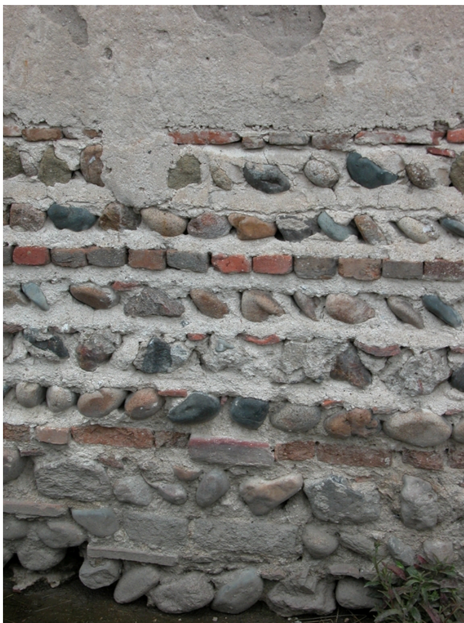
Détail de matériau : soubassement du logis en maçonnerie de galets, molasse et briques ou tuiles.
