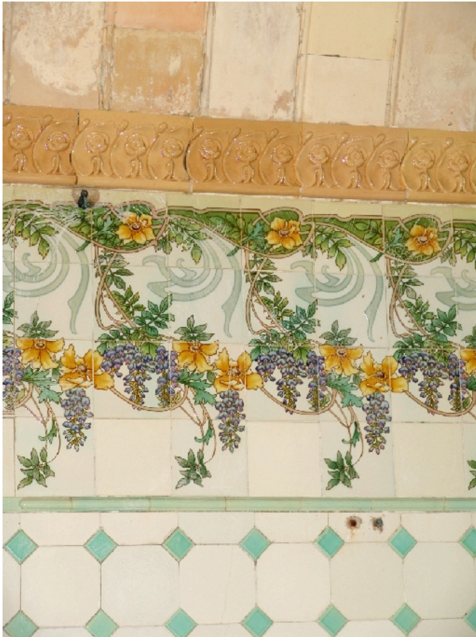
Etage de soubassement : cabine, détail du décor
