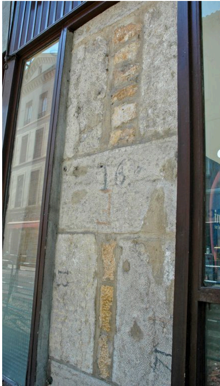
Détail des matériaux de façade, avec marques de pose
