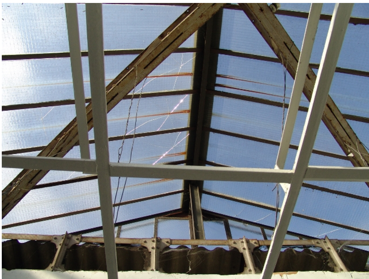
Verrière zénithale, détail
