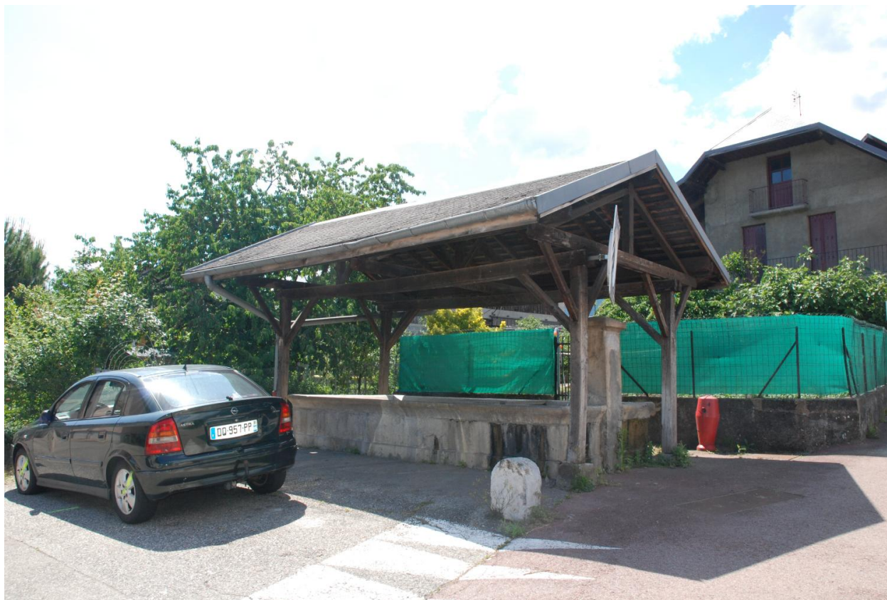
Bassin (fontaine, lavoir, abreuvoir) couvert (2018 D3 841).
