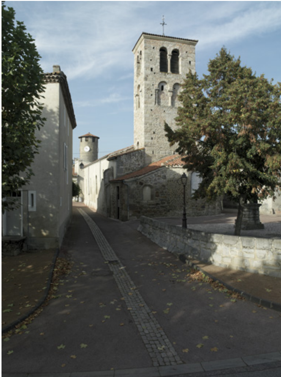
Vue d'ensemble de l'église de trois quarts sud-est
