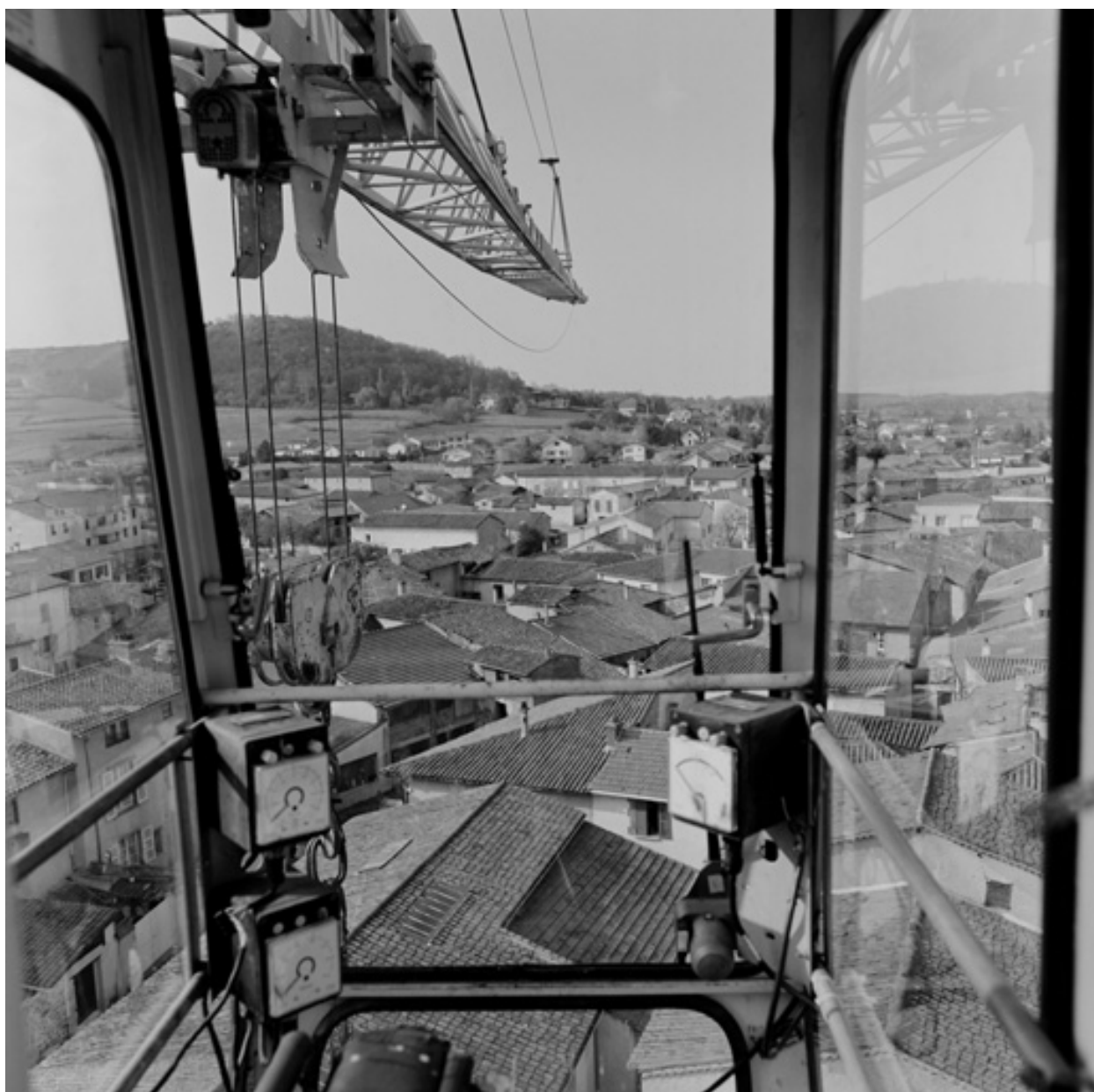
Le Bourg, rue des Caves. Vue des toitures depuis une grue implantée sur la parcelle 160, vers le nord.
