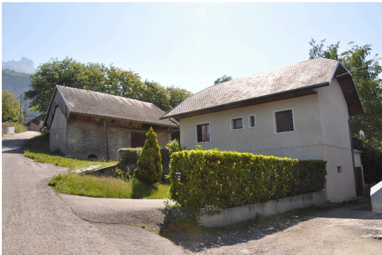
Vue des moulins Bizet, vue sud-ouest
