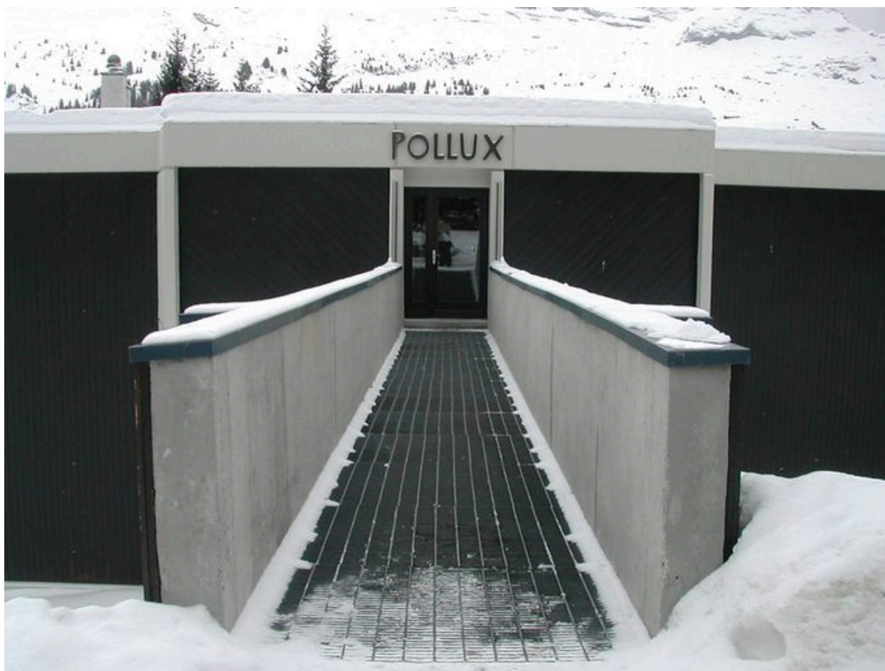
La passerelle d'accès
