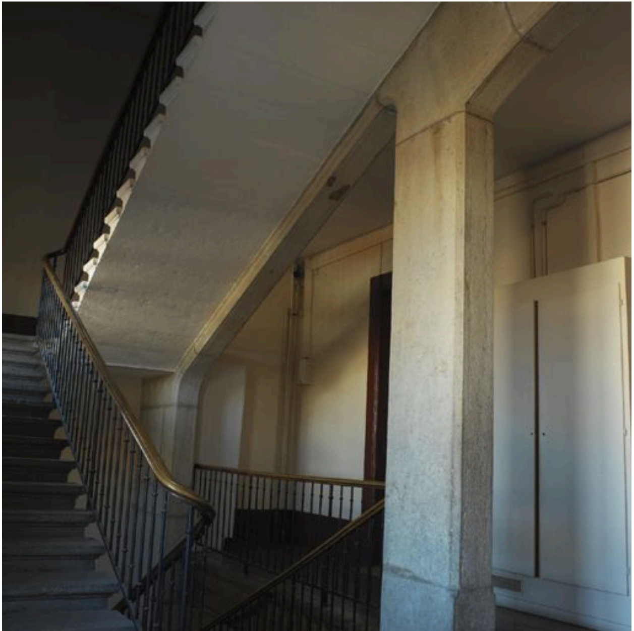
Les arcs rampants ouvrant sur les paliers de l'escalier du corps de bâtiment sud
