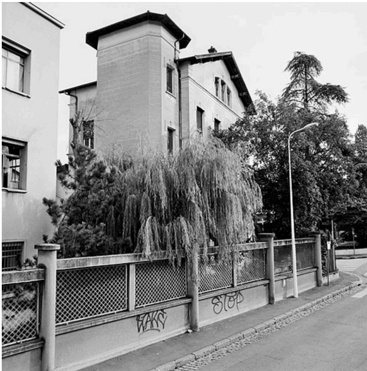
Vue sud-ouest de l'ancienne maison directoriale, rue Gorge de Loup
