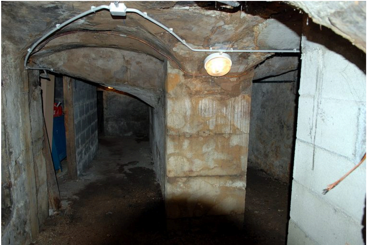
Vue partielle de la cave
