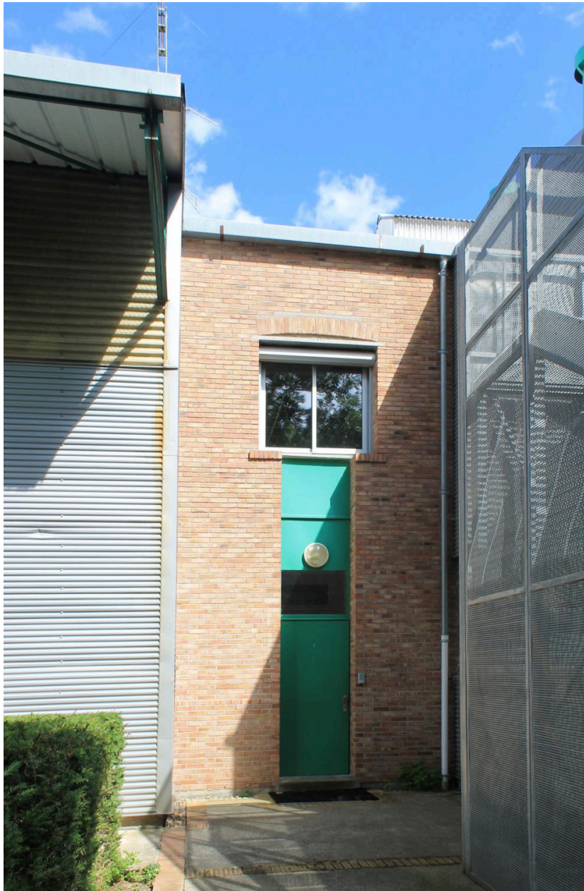
Billom, subdivision de la DDE, détail de la façade nord-ouest à la jonction des deux ailes.
