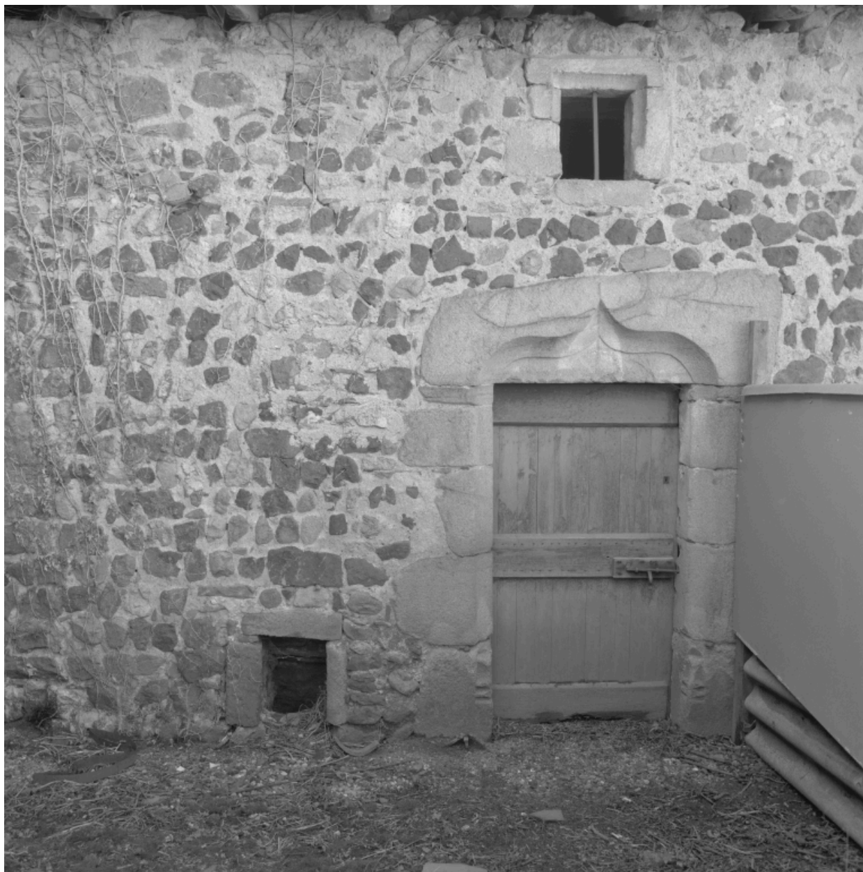
Détail de la porte de la façade donnant vers l'église.
