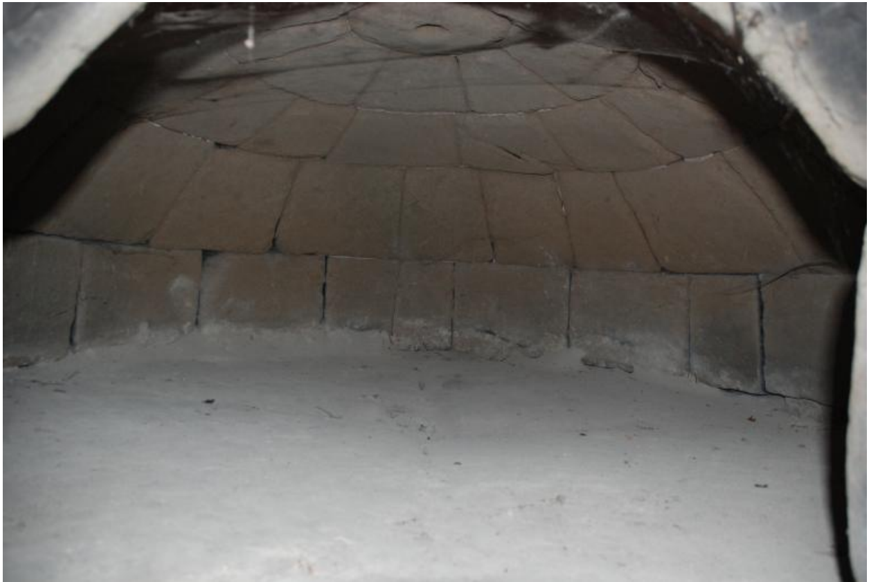
Détail de la voûte du four.
