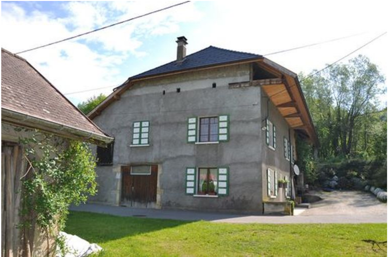
Mur pignon du bâtiment du moulin
