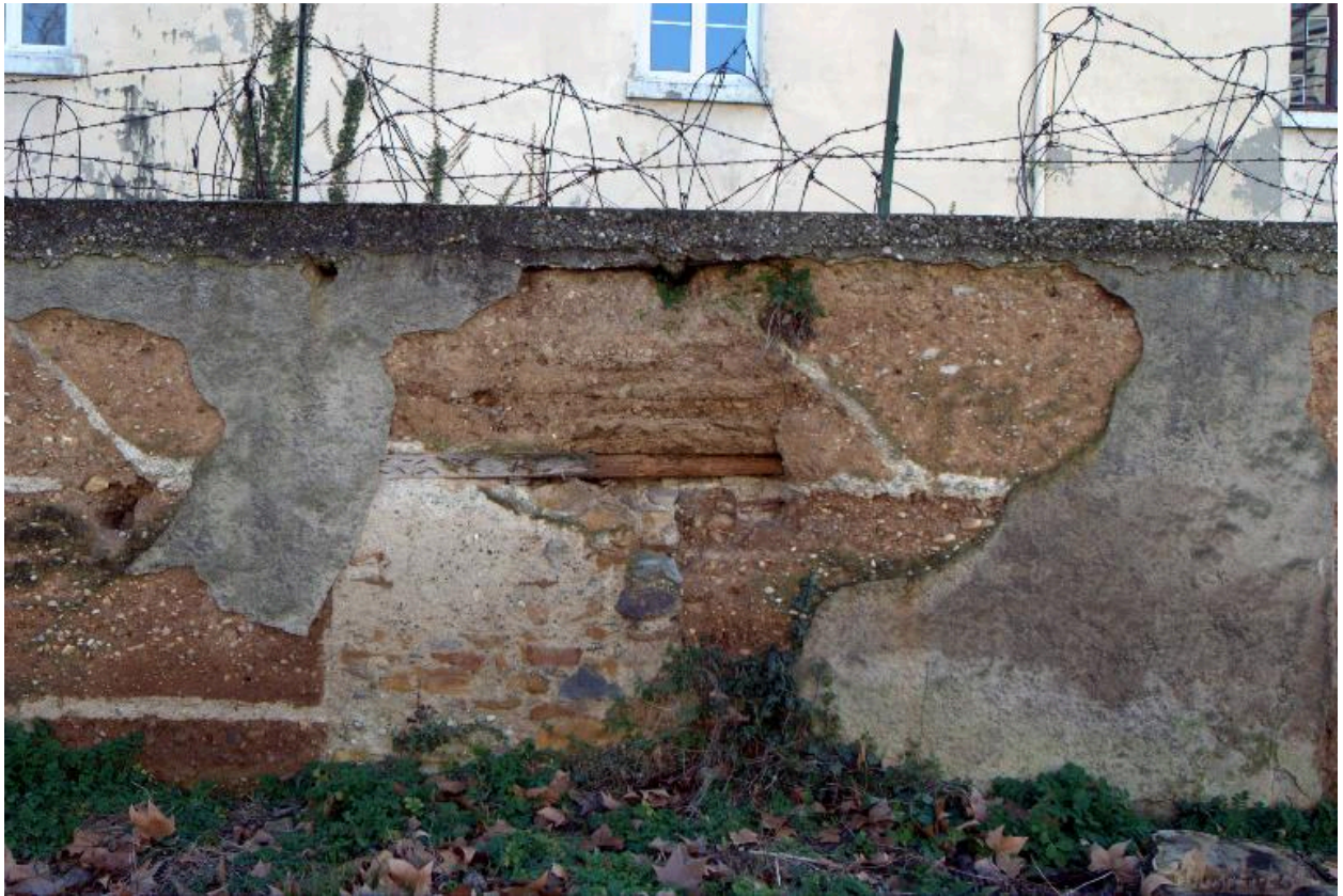
Mur de clôture en pisé, détail
