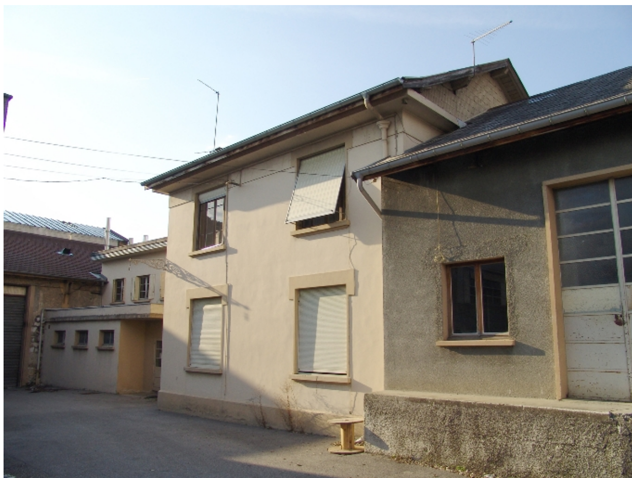
Façade sur cour vue de trois-quart droit
