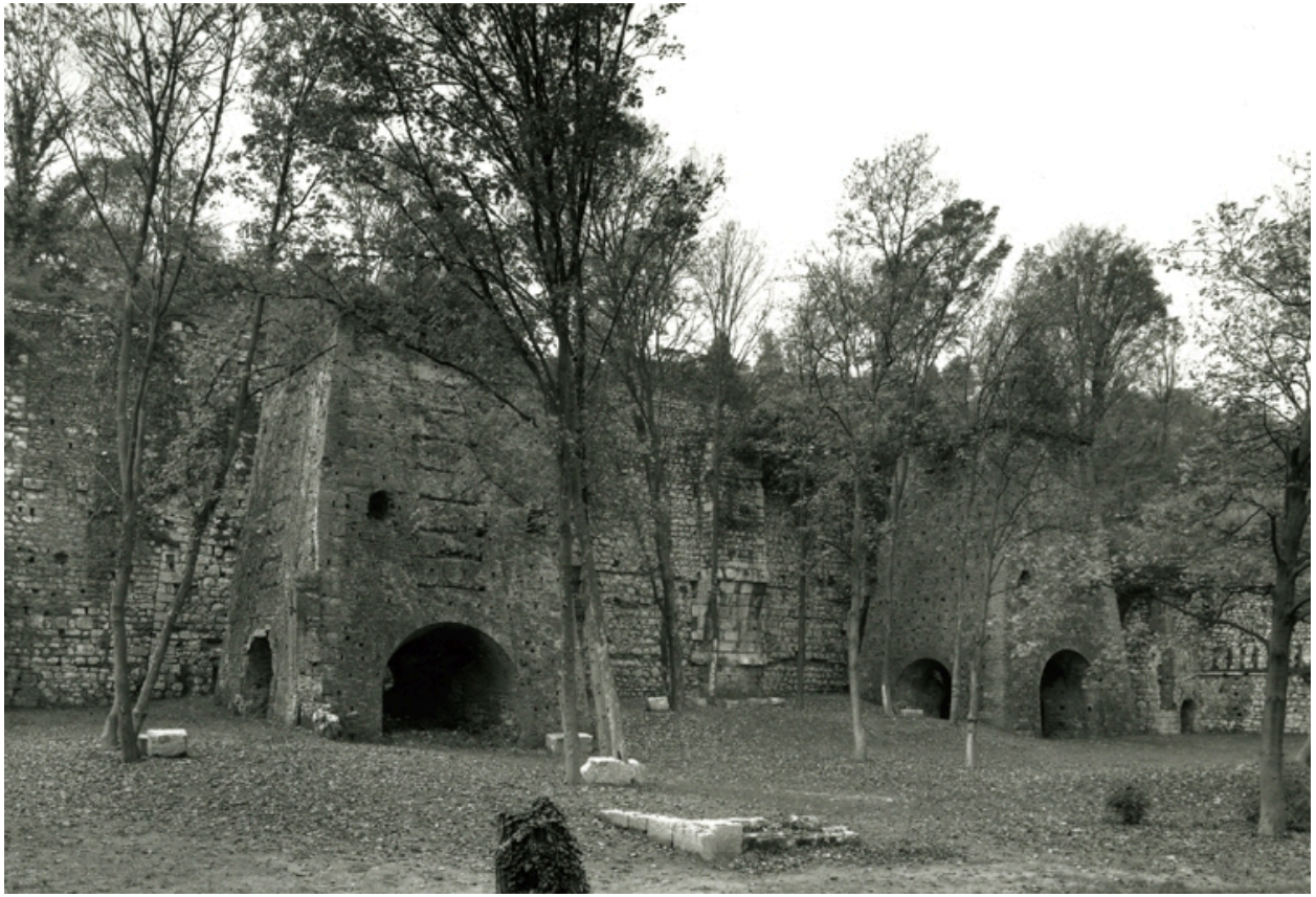
Vue des hauts fourneaux
