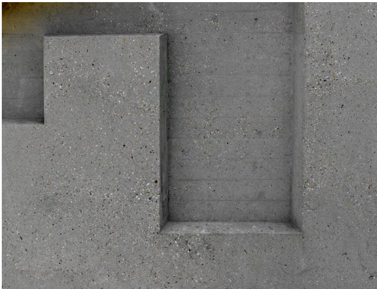
Détail de la mise en oeuvre du béton (paroi nord).
