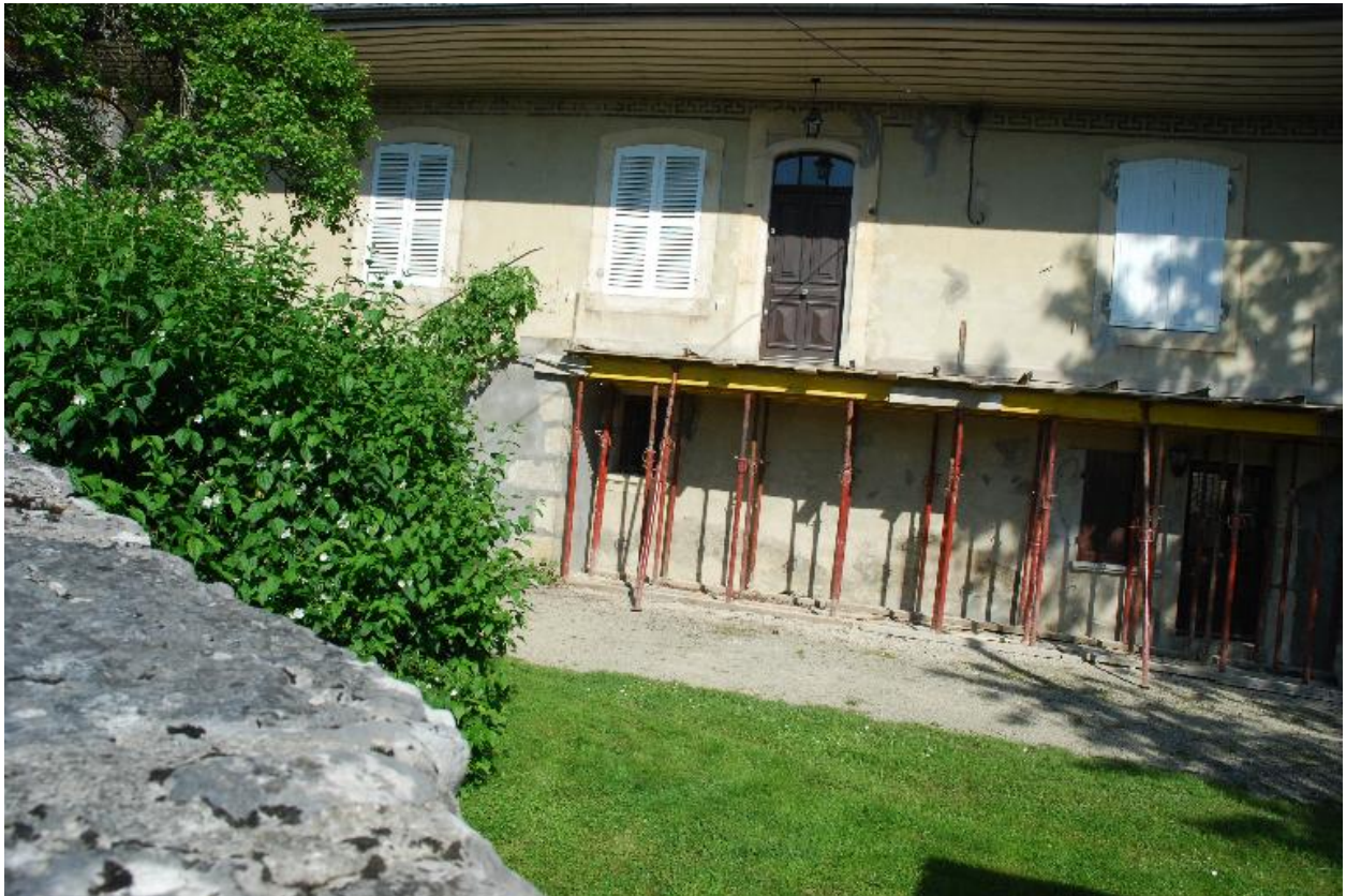
Vue partielle de la façade sur cour.
