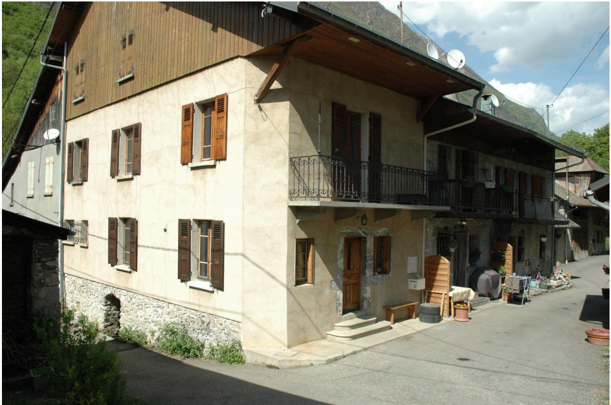
Maisons de vigneron (2018 A5 1042, 10433), vue d'ensemble depuis le sud-ouest (angle de la rue de la Forteresse).
