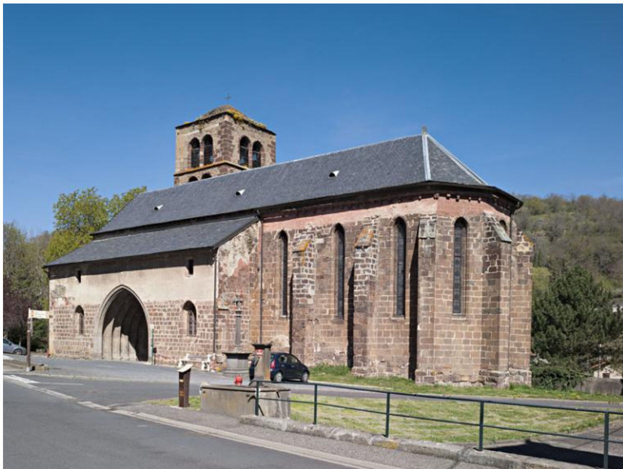
Vue générale côté sud.
