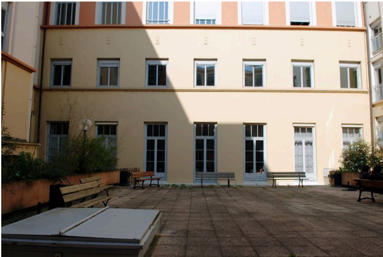
Cour intérieure, élévation postérieure ouest, détail des premiers niveaux
