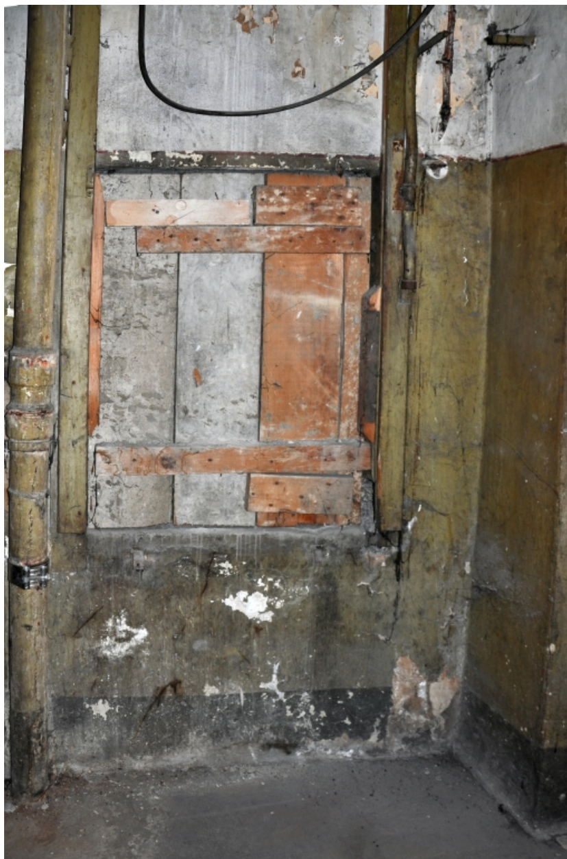
Sous-sol de l'aile N-W : ancien puits ?
