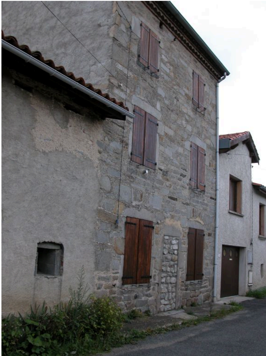
Surizet (le), Ferme 1986 AR 159. Ancienne ferme vue depuis la rue.
