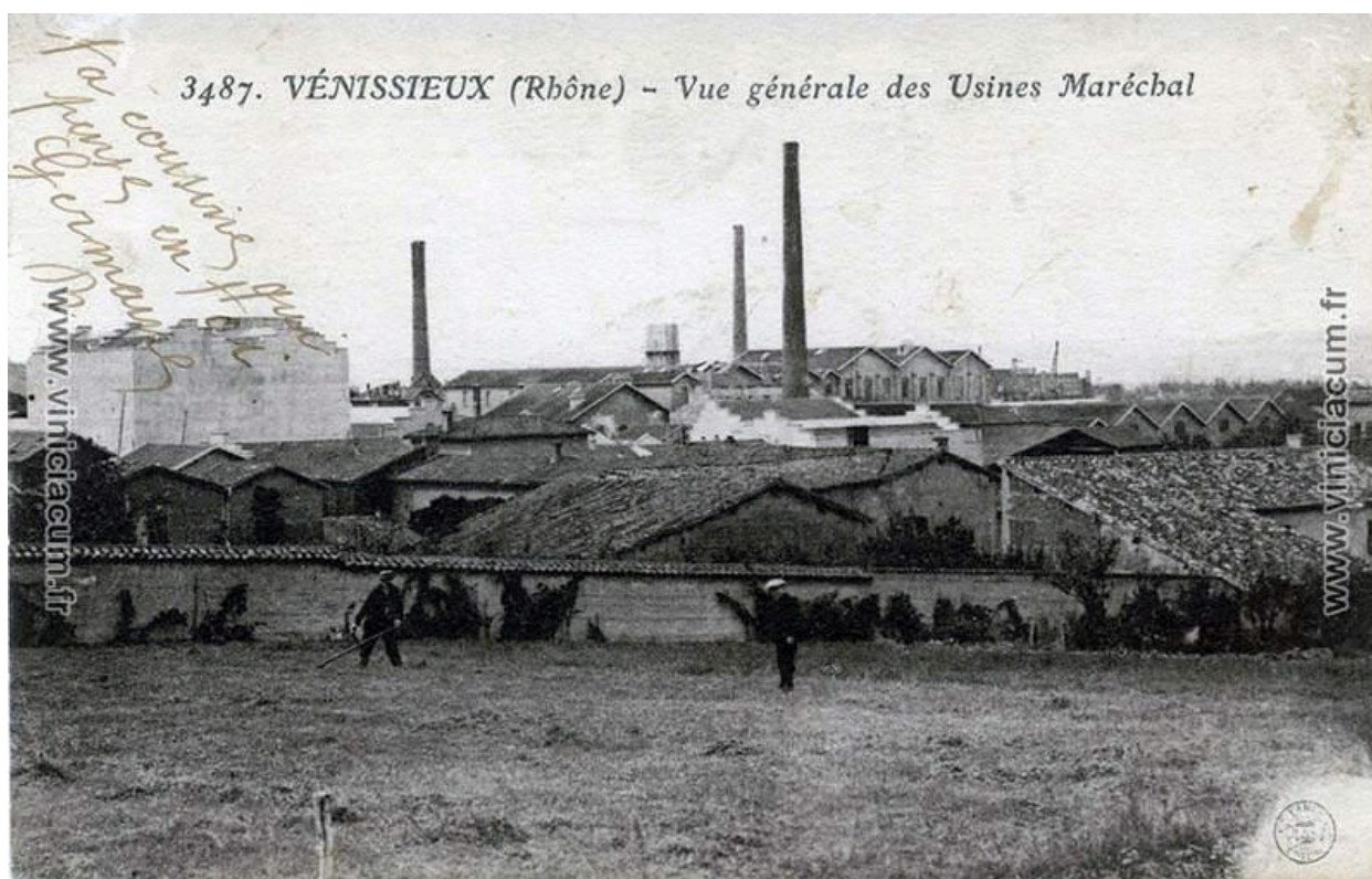
Vénissieux (Rhône) - Vue générale des Usines Maréchal (Association Viniciacum)
