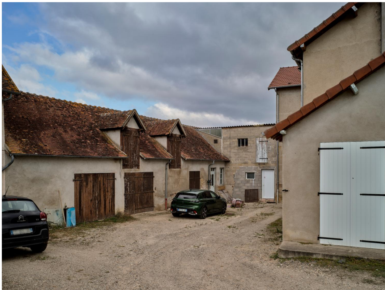
Vue des bâtiments de la ferme au nord-ouest
