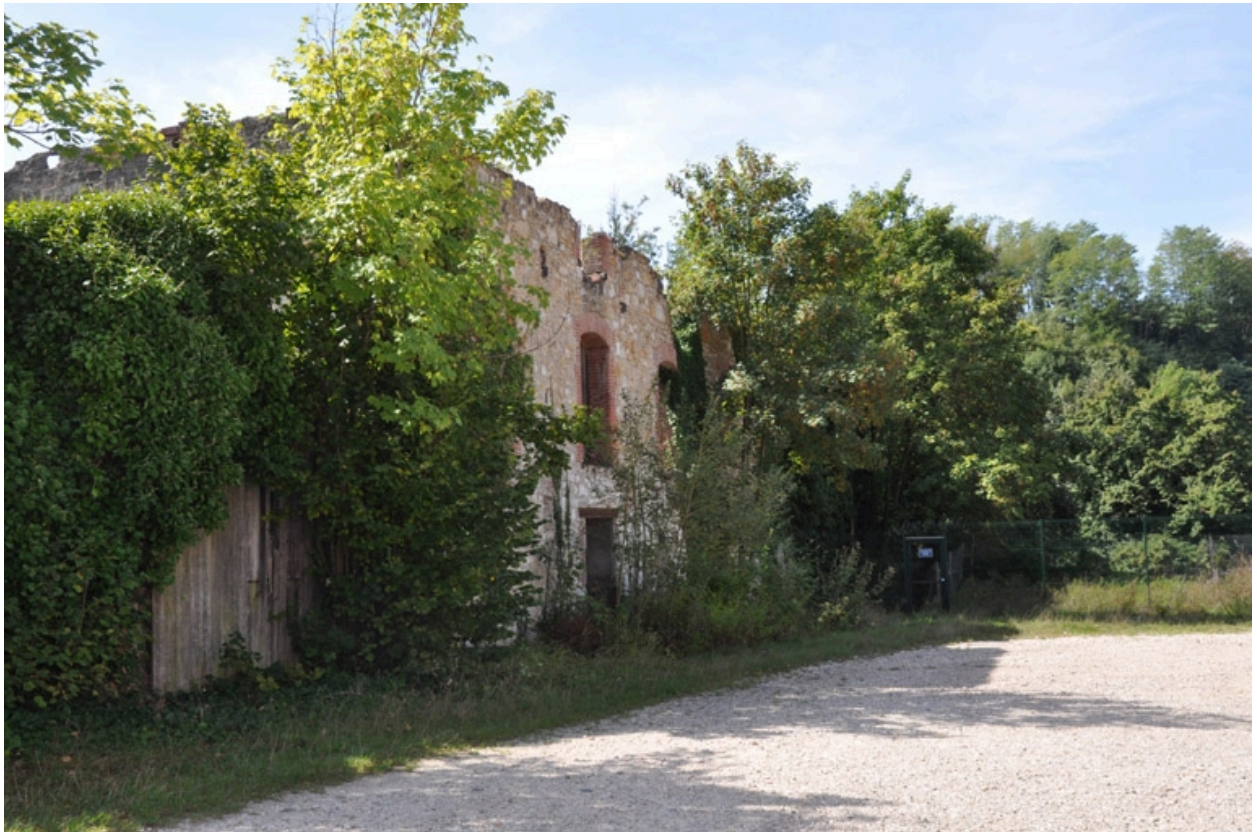
Vue générale de l'ancienne scierie, façade nord-ouest
