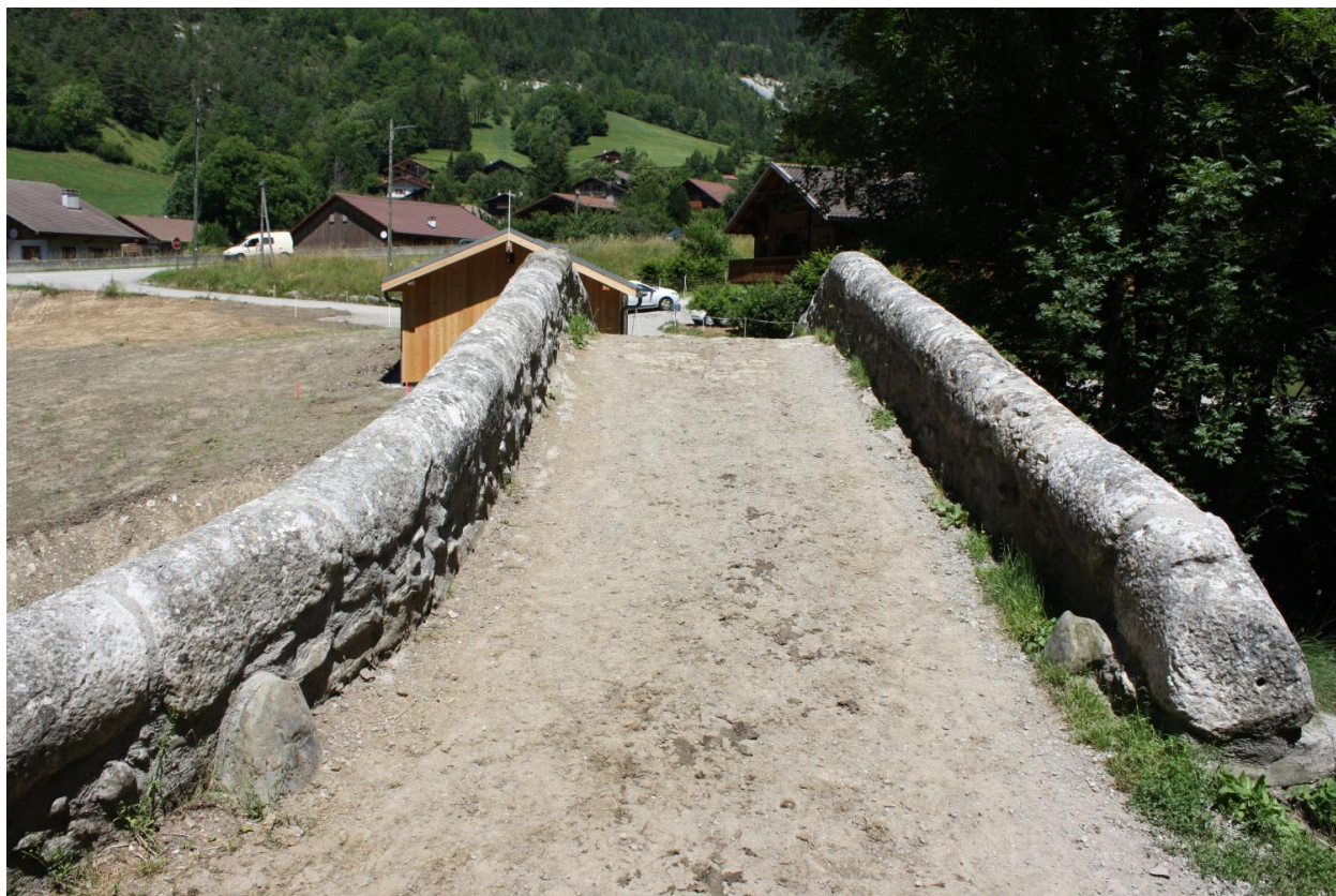
Pont de la Vacherie, chaussée et gardes corps
